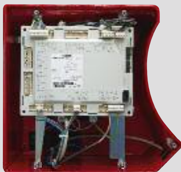
Менеджер горения W-FM100 или W-M200 на корпусе горелки
