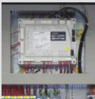
Установка в шкафу управления
