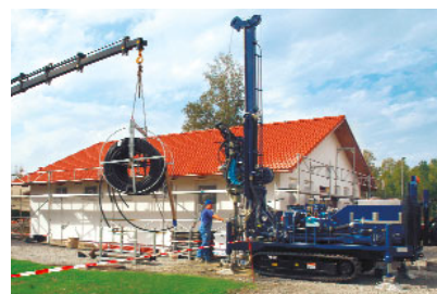
Бурение под земляные зонды фирмой BauGrund Süd
